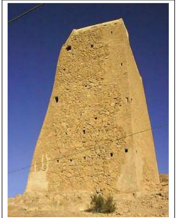
اللوحة 88 : الواجهة الشمالية، وفي طرفيها تظهر الترميمات القديمة التي مسّت الواجهتين: الشرقية والغربية.
