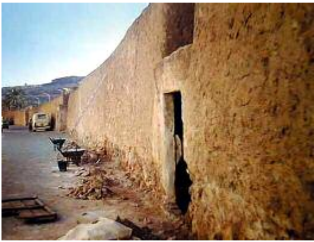
اللوحة 56 : الطبانات أثناء عملية الترميم.
