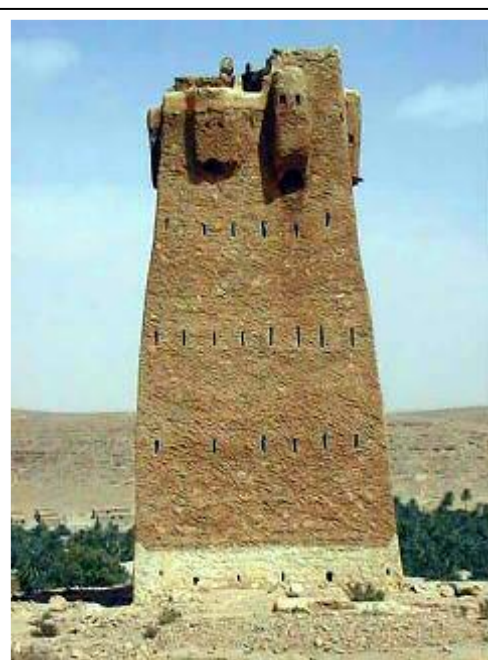
اللوحة 78 : برج زليقة الفوقاني، الواجهة الغربية.
