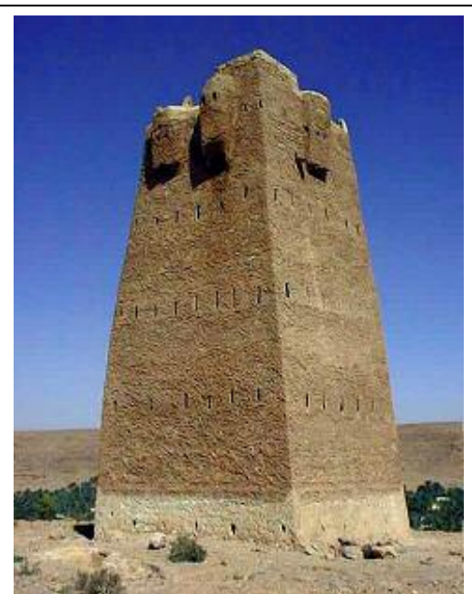
اللوحة 80 : برج زليقة الفوقاني، الواجهة الغربية.
