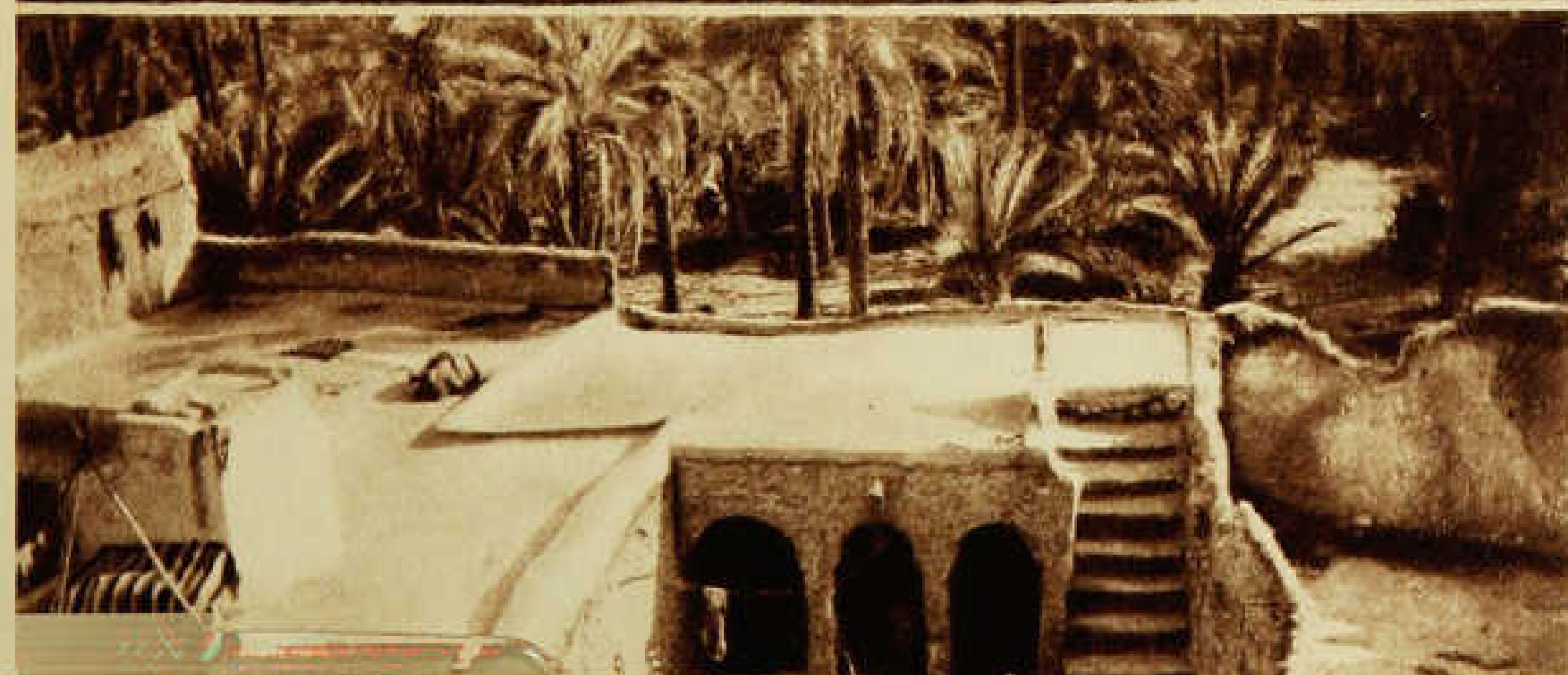
La terrasse et l'étage d'une maison mzabite
