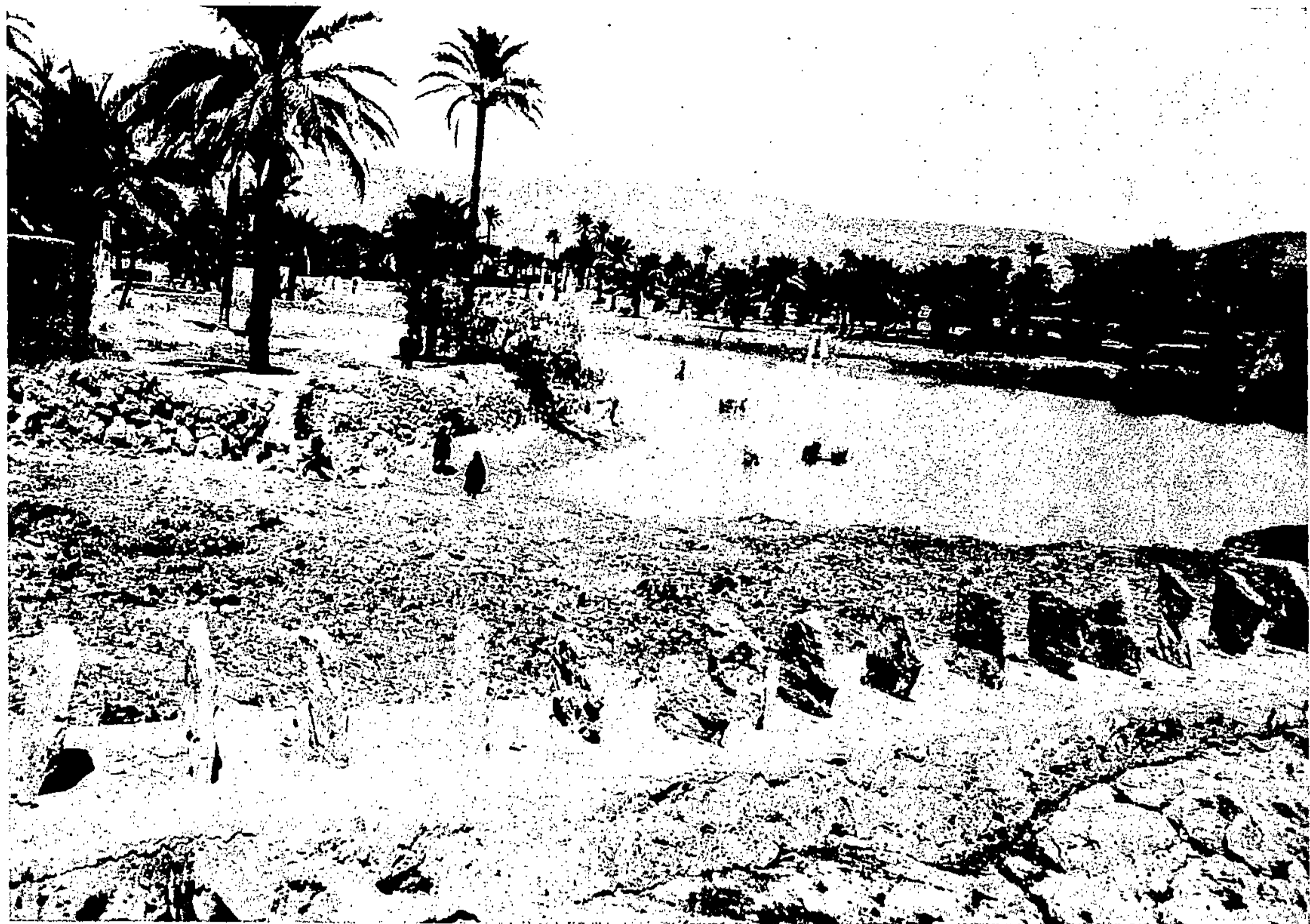
GHARDAÏA. — Le barrage sur l'oued ; spectacle rare : il y a de l'eau ! On remarquera, au premier plan, les brise-lames barbares, pour les pluies diluviennes.
